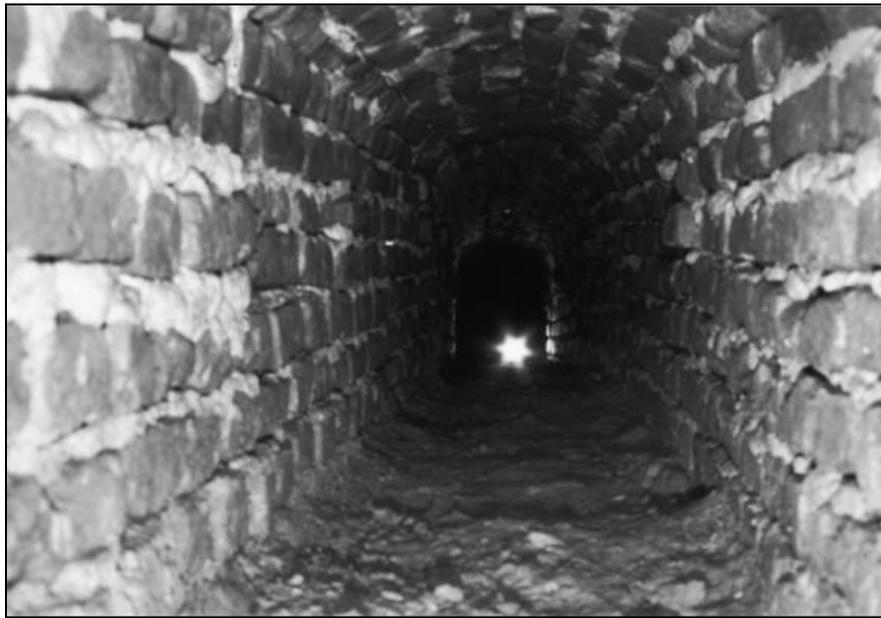
Figura 46 - **GALLERIA CONTROMINA**. Posta a circa 250 metri dal Dongione, alcuni metri sotto la vecchia vigna sul lato della frazione Faldella. Lunga circa 40 m, le misure approssimate sono di cm 60 x 60. Foto: Massimo Ottino.
