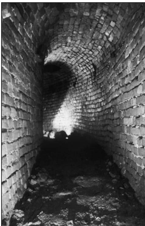
Figura 49 - **GALLERIA.** Posta nelle immediate vicinanze del pozzo di cui alla fig. precedente, misura  $m\ 2,5 \times 1$ . Lunga circa  $m\ 30$ , è erosa da entrambi i lati dalla cava. Foto: Massimo Ottino
