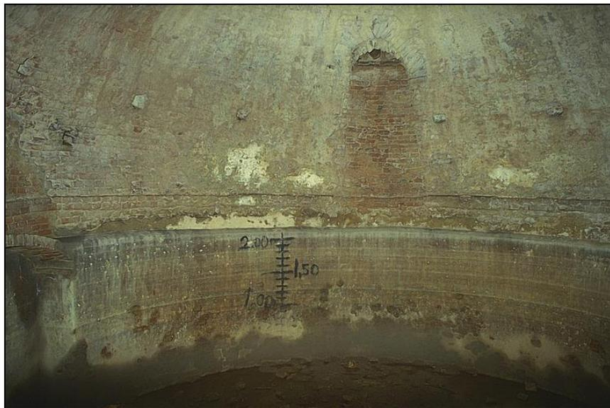
Figura 30 - **CISTERNE.** *Fungevano da raccolta dell'acqua piovana ed erano in uso per l'irrigazione agricola fino al 1955.*
