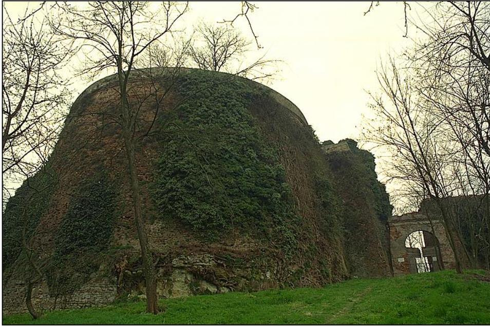
Figura 25 - **DONGIONE E PORTA DI INGRESSO.** *Si noti come la vegetazione stia ormai minando in maniera preoccupante l'integrità della struttura.*
