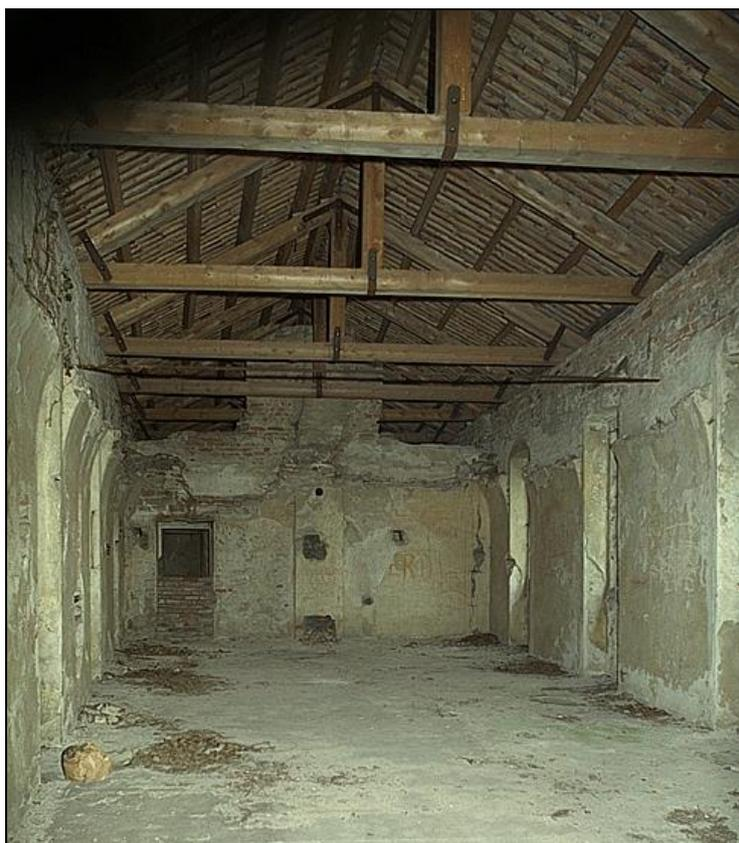
Figura 35 - **INTERNO ABITAZIONE DEL MARCHESE.** *Si noti in alto il rifacimento delle travi del tetto, in seguito alla convenzione stipulata nel 1989 tra il Comune di Verrua e l'impresa cementifera per il rinnovo della concessione della cava.*
